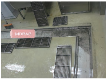
創洗浄室の排水溝の中まで徹底洗浄
